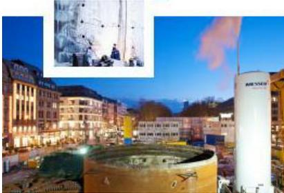
Die Kälte von flüssigem Stickstoff stabilisiert das Erdreich bei Tiefbaustellen.
