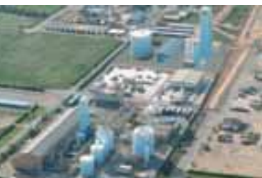
Gase aus der Luftzerlegungsanlage werden über ein Pipelinenetz an die Kunden geliefert.
