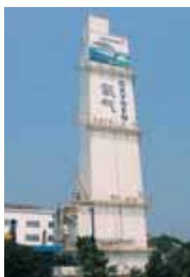
Der dritte Luftzerleger bei der Xiangtan Iron & Steel Group in der Provinz Hunan ging im März in Betrieb – und fungiert gleich als Werbeträger für die Produkte der Messer Gruppe.
