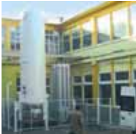
Kuhnke nutzt in Rumänien flüssigen Stickstoff zum Inertisieren beim Löten von Elektronikbauteilen.
